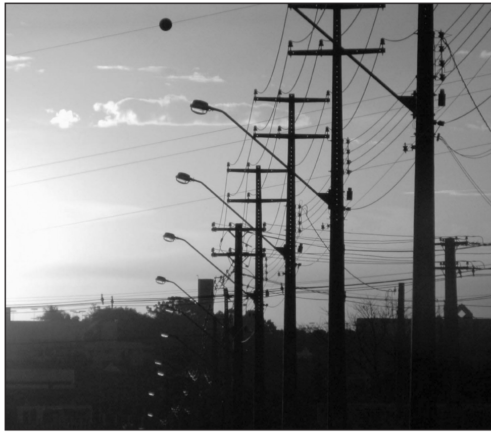
Sistema terá potência instalada total de 5,36 MWp, suficiente para atender o consumo de energia de aproximadamente 10 mil habitantes
